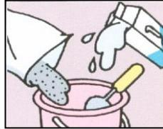
適量の乾燥生コンを入れた容器に、水を少しずつ加えながら、シャベルなどでよく練ります。水の量は用途に応じて加減して下さい。
